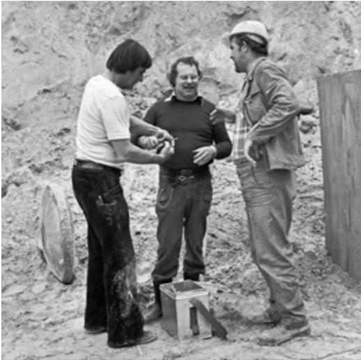
Friederich Wertmann (links) und erfahrene Sprengmeister bereiten eine Sprengung vor. Die an einem Holzstab befestigte Sprengladung wird in die Mitte gehalten und mit aufgefülltem Sand dort gehalten. Der Sand sorgt zudem für eine gleichmäßigere Kraftverteilung.
